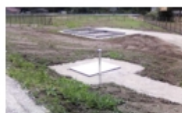
Vue générale de la station
